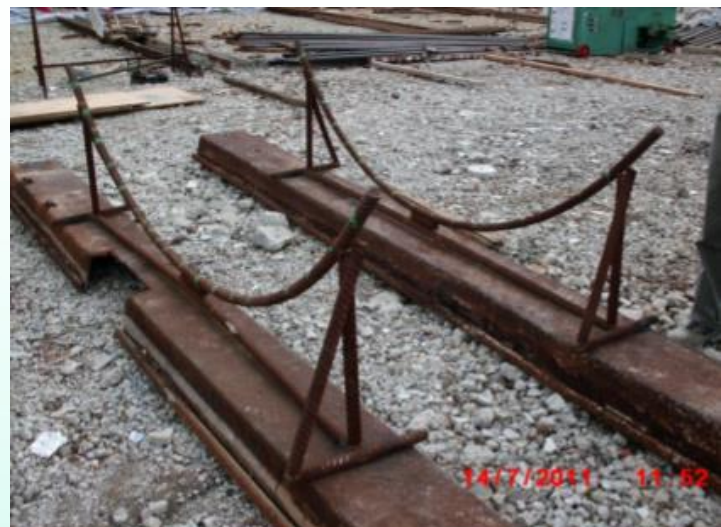
穩固鐵籠的弧形結構支架
