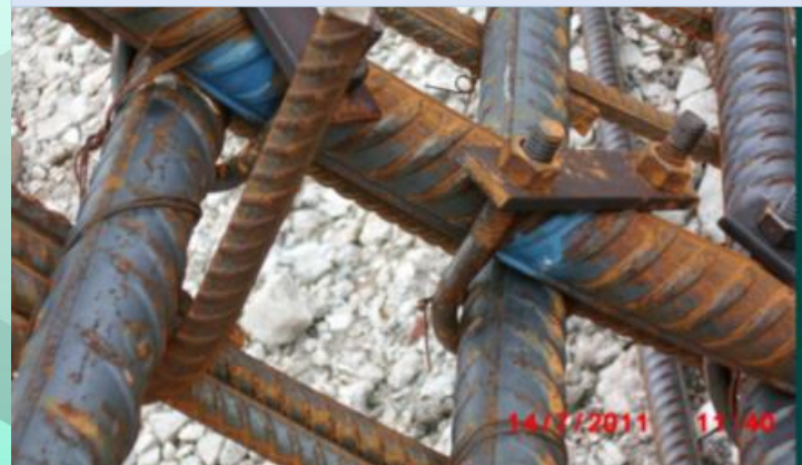
當用鐵線將鋼筋及金鋼圈定位後， 須立即用 U-碼上緊
