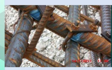
當用鐵線將鋼筋及金鋼圈定位後, 須立即用 U-碼上緊
