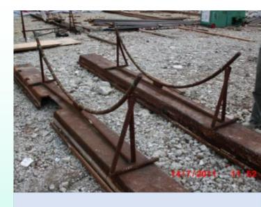
穩固鐵籠的弧形結構支架
