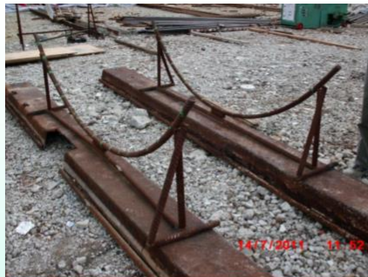
穩固鐵籠的弧形結構支架
